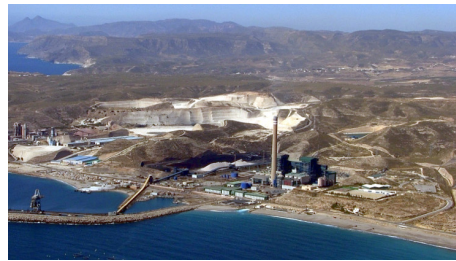
Figura 3.2: Central térmica de generación eléctrica
